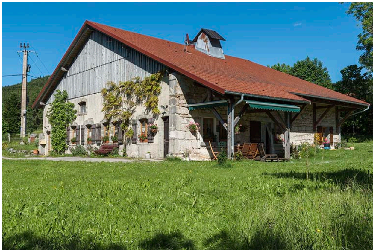
Façades antérieure et latérale droite.
