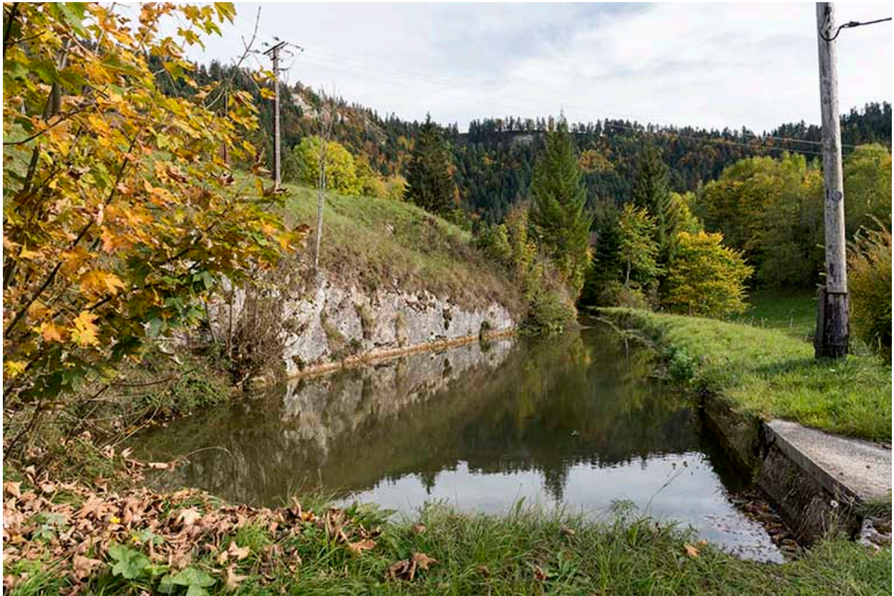
Bassin de retenue.
