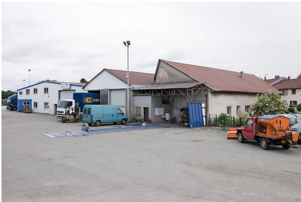
Vestiges d'un bâtiment industriel (à droite).
