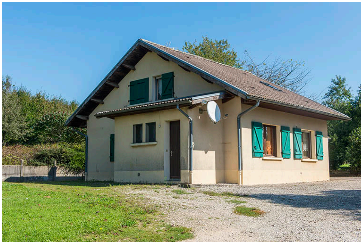
Angle sud-ouest du logement.
