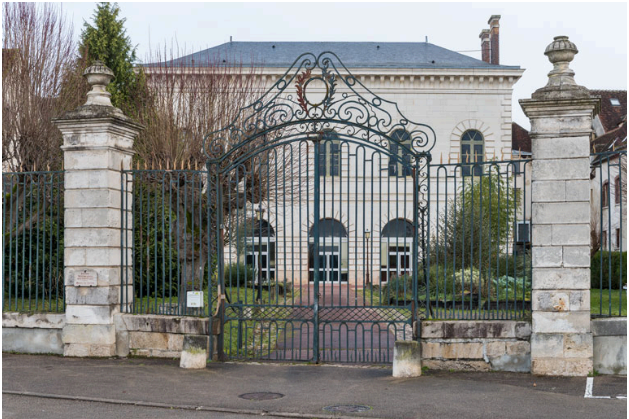
Grille dite "de Paris" (réputée dater de 1758), vue du quai du Général Leclerc.
