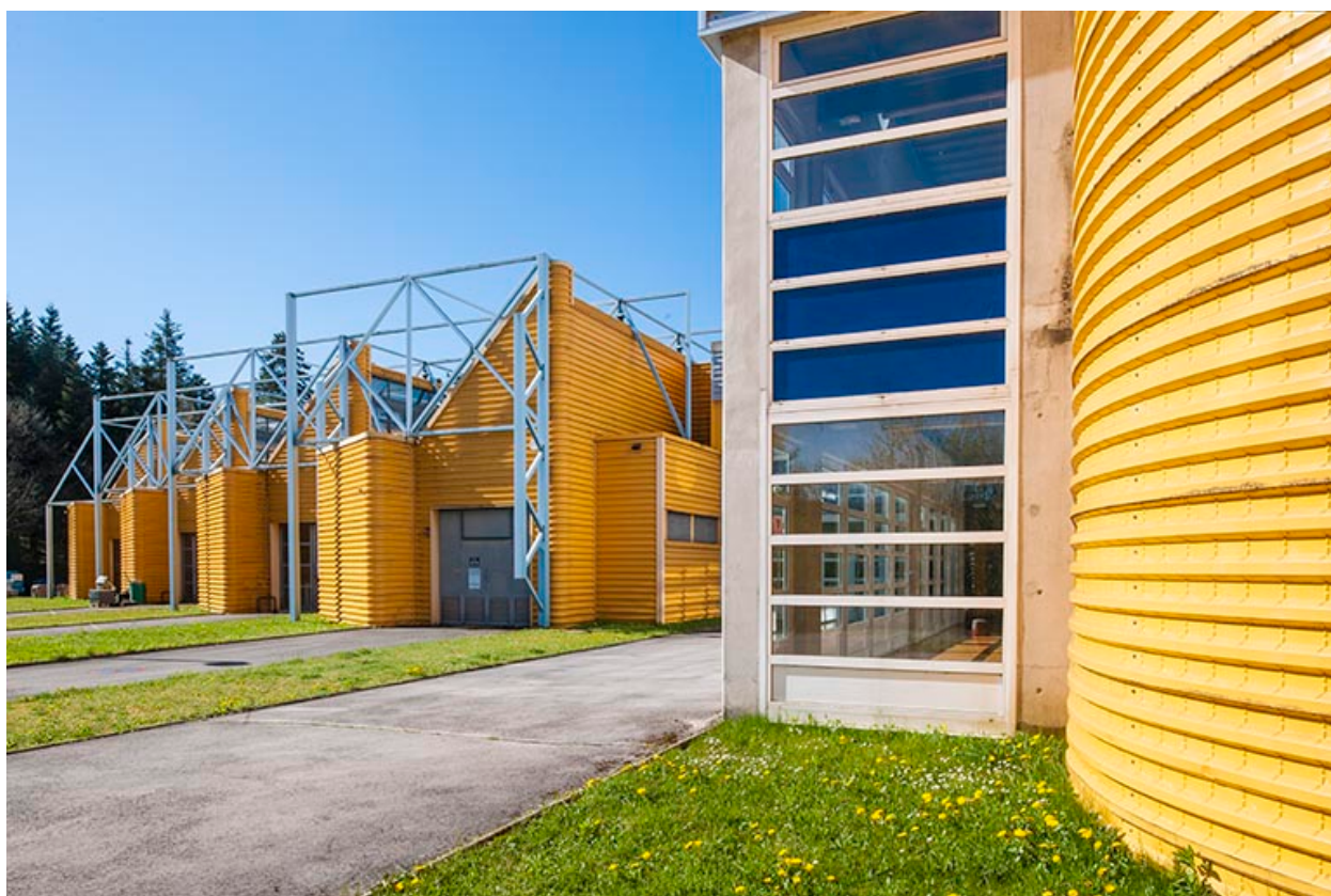
Atelier : façades Nord, détail
