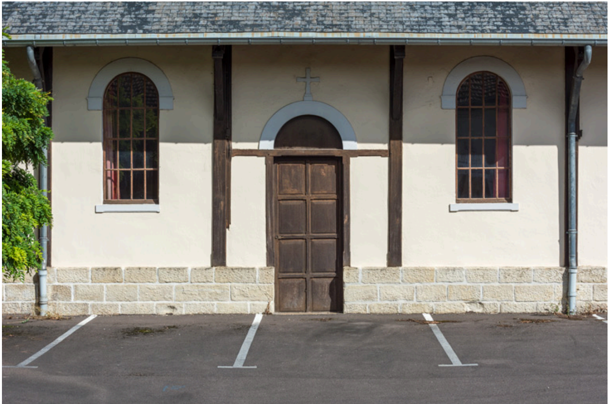
Façade ouest. Vue de trois travées.
