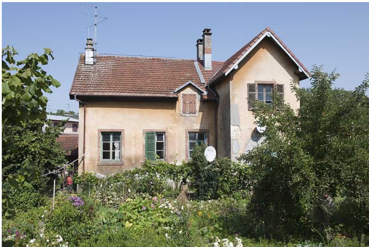
Façade sud de l'école.
