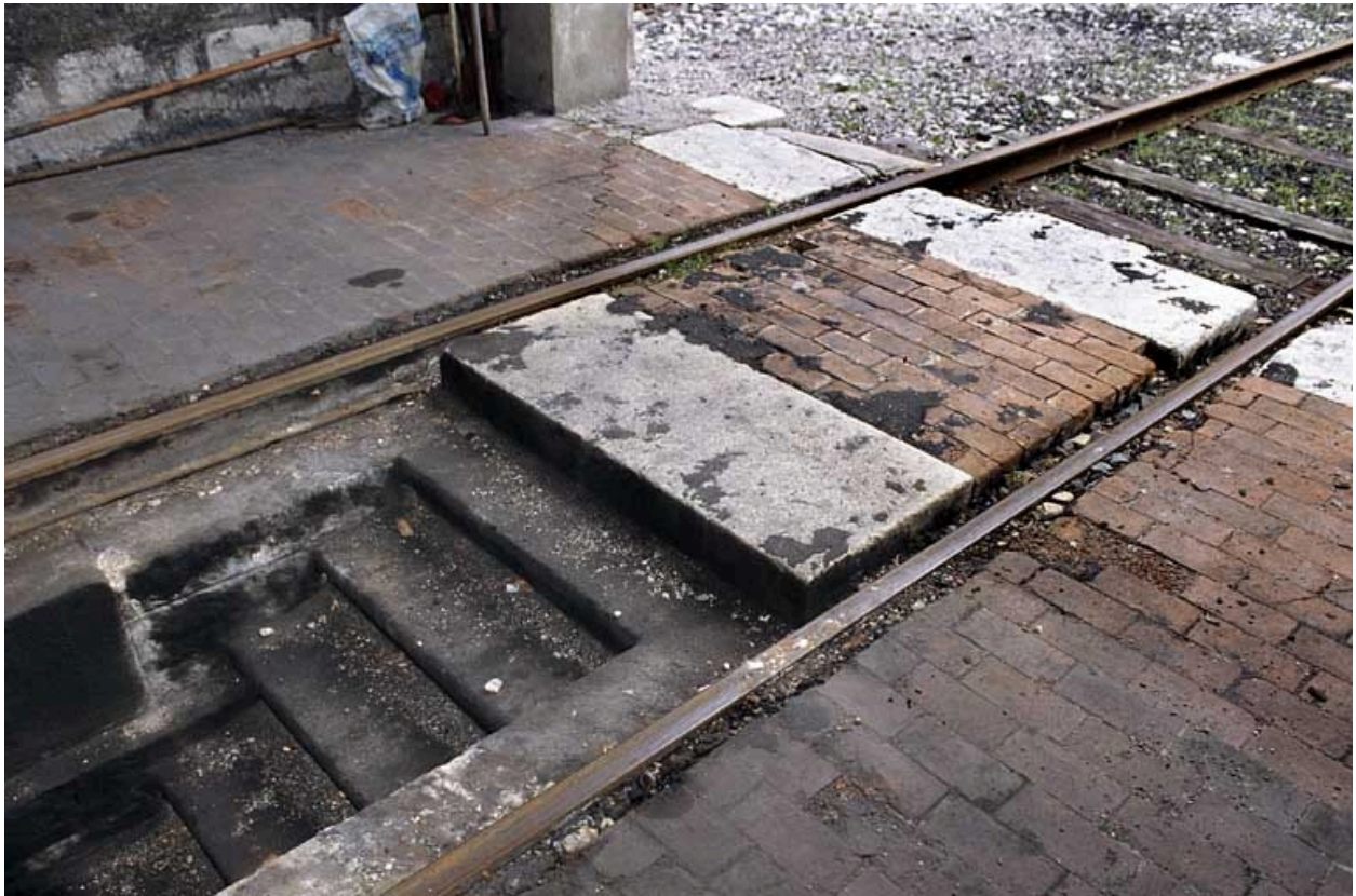
Remise ferroviaire : escalier d'accès à la fosse dans la halle est.
