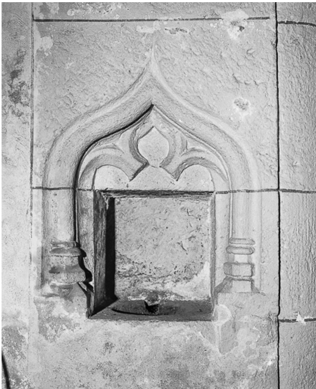
Lavabo de la chapelle latérale gauche.
