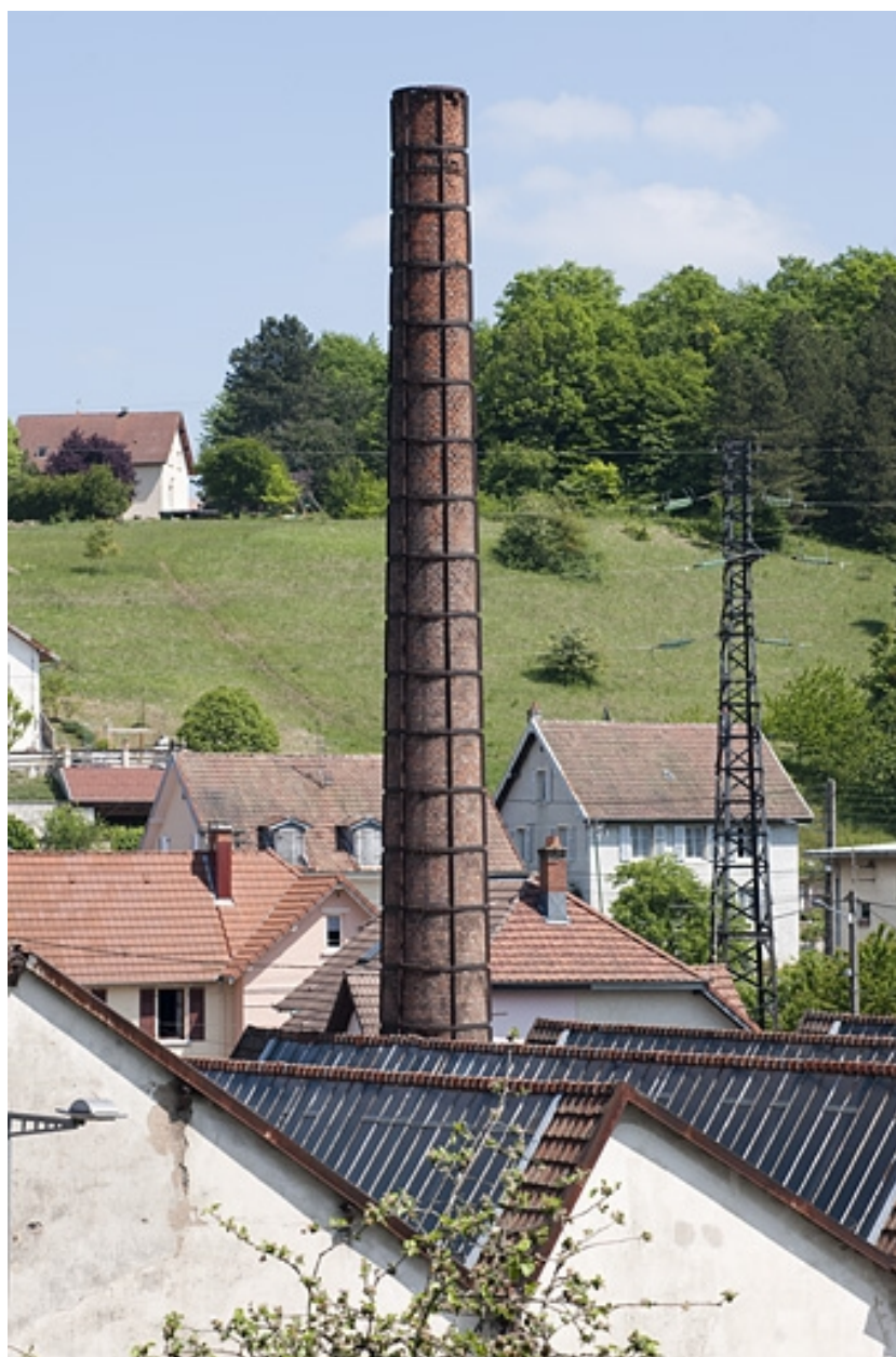
Sheds et cheminée de l'atelier de laitonnerie.
