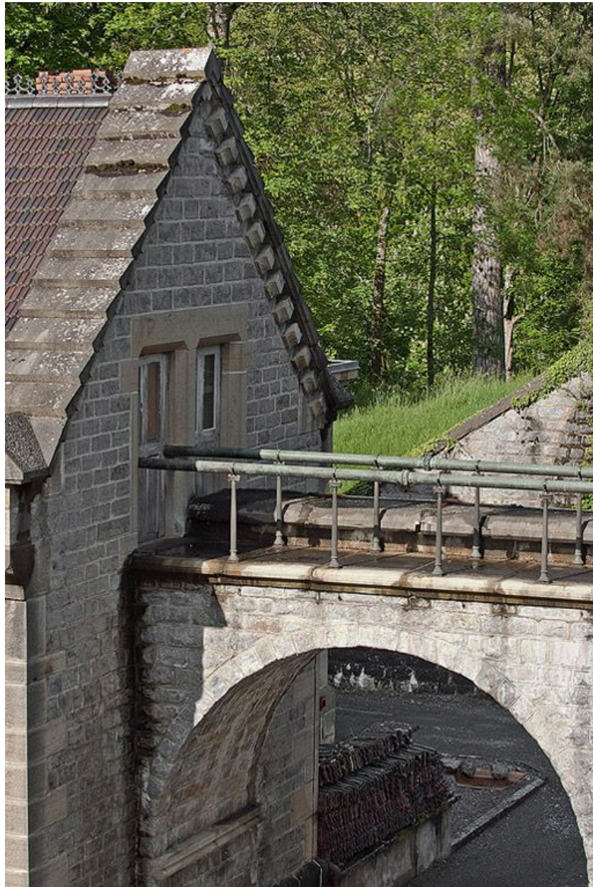
Aqueduc entre le réservoir et les bains d'Aligre (à gauche).
