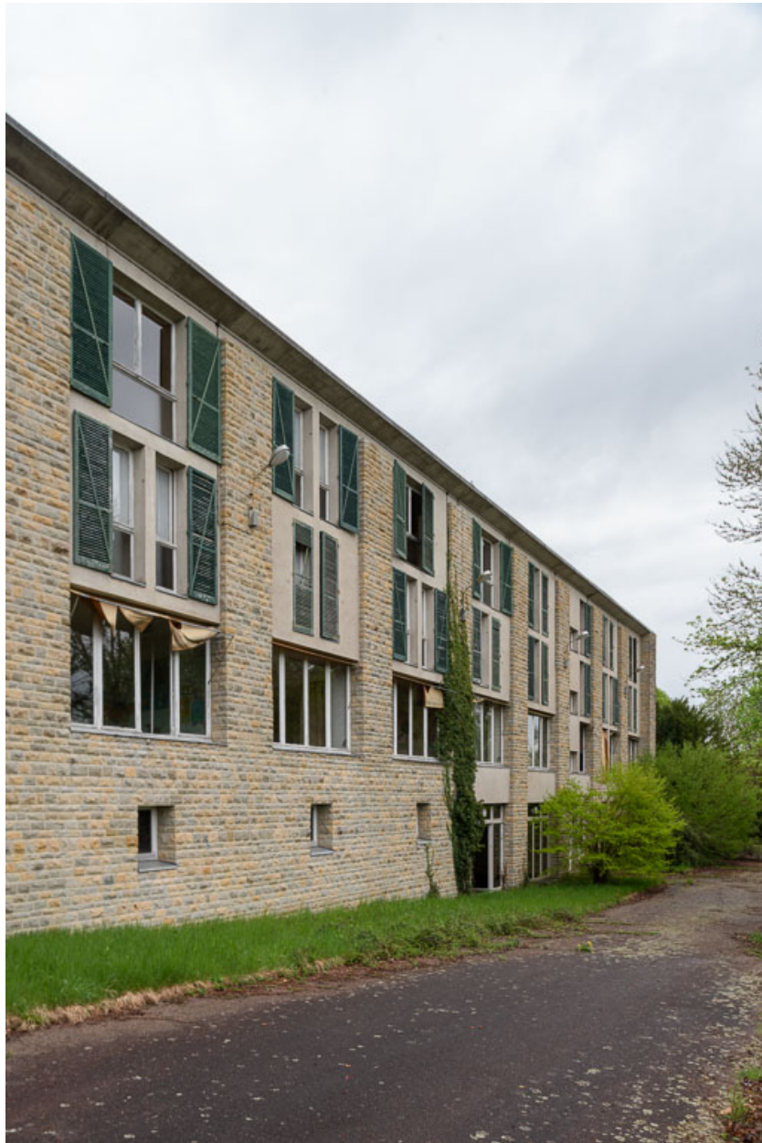
Élévation extérieure du corps de bâtiment principal.
