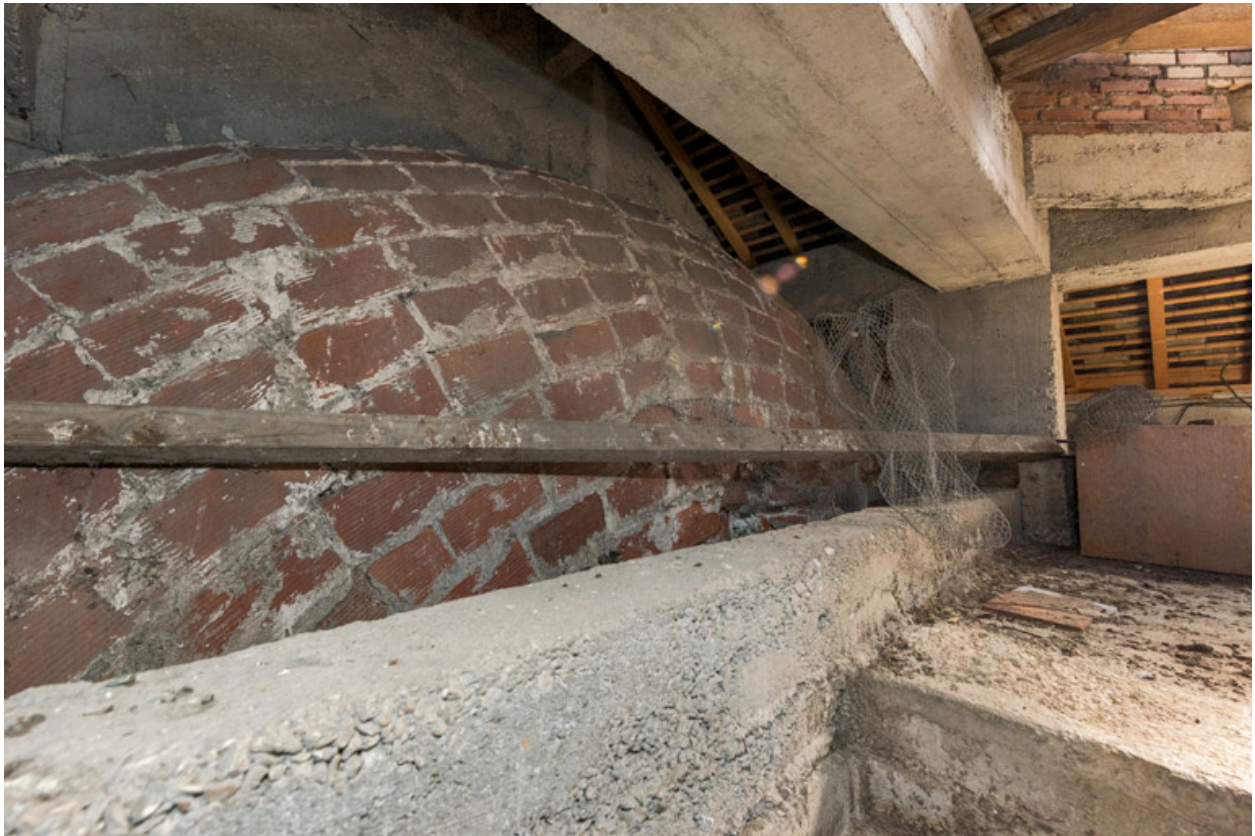
Voûte et charpente.
