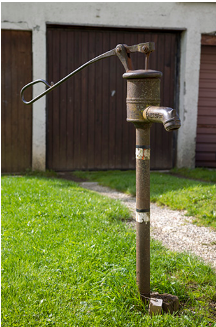
Pompe à eau Renaud, aux Fontenelles.
