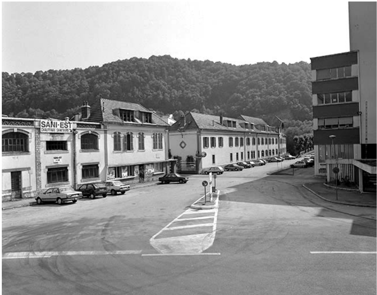
Façade sur rue de la conciergerie (N) et des bureaux (M).
