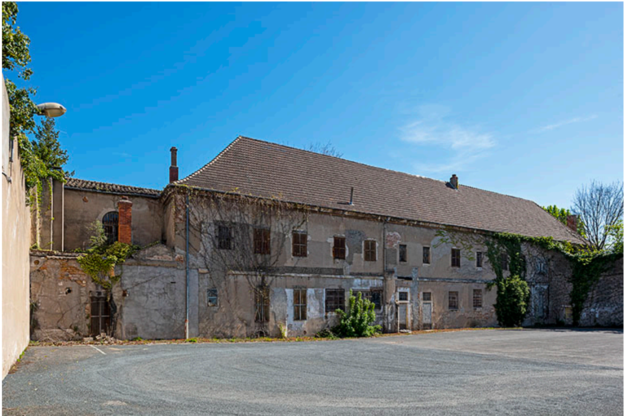
Façade de la prison depuis la grande cour.
