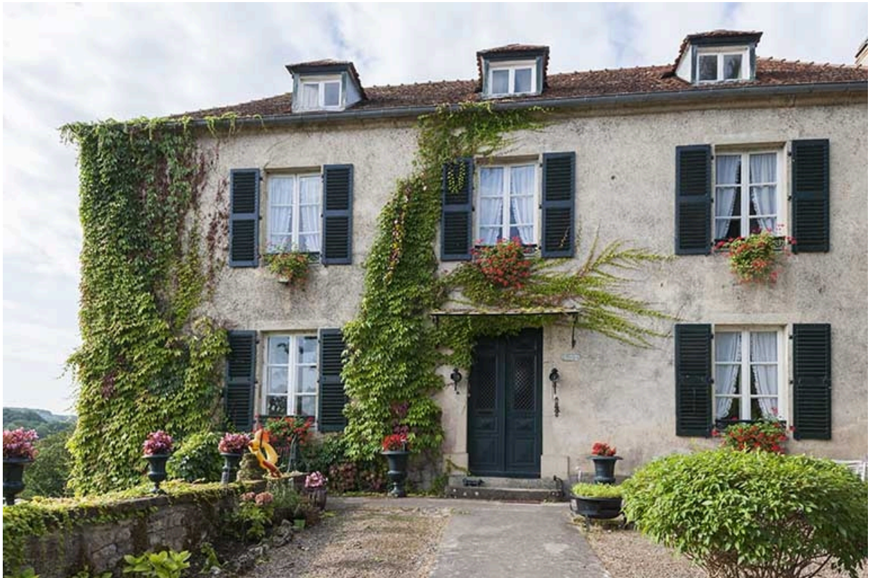
Façade antérieure sur cour.
