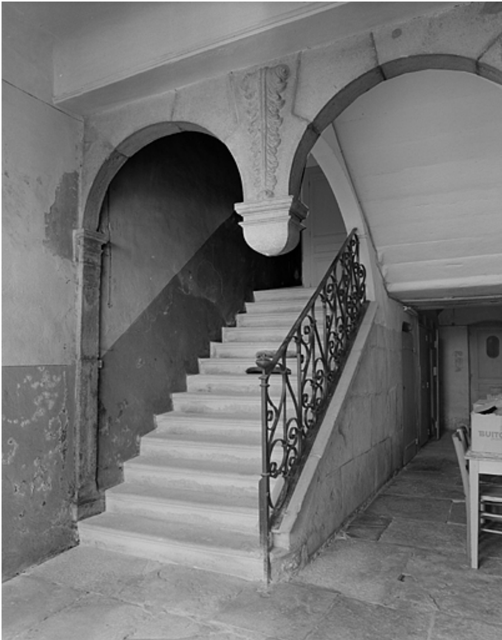
Détail de l'escalier intérieur dans le corps de bâtiment sur rue.
