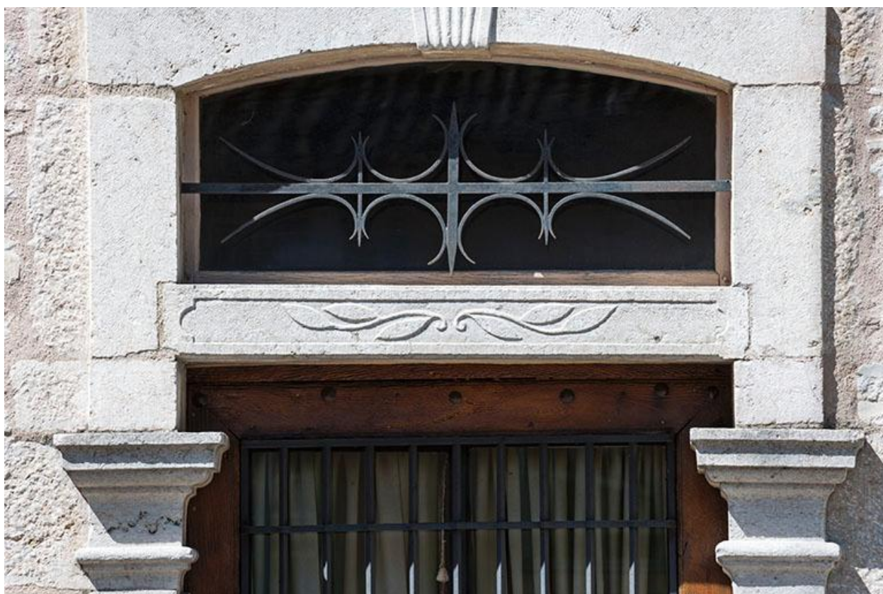
Détail de l'imposte au-dessus de la porte
