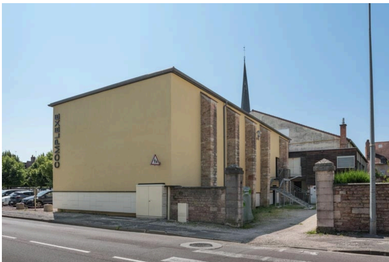
Façades postérieure et latérale droite.
