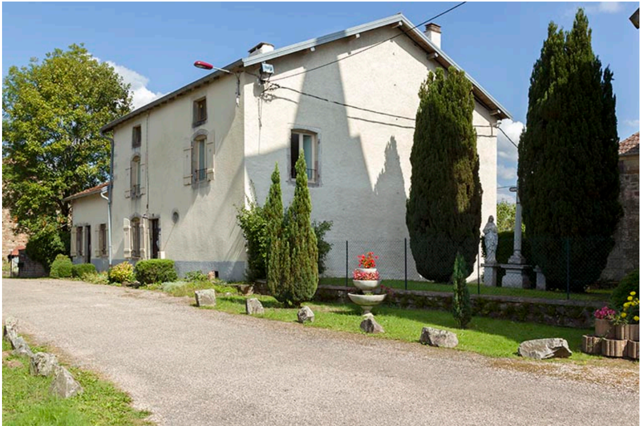
Façades postérieures et latérale sud.
