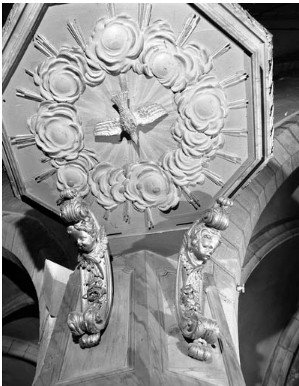
Détail du plafond de l'abat-voix.
