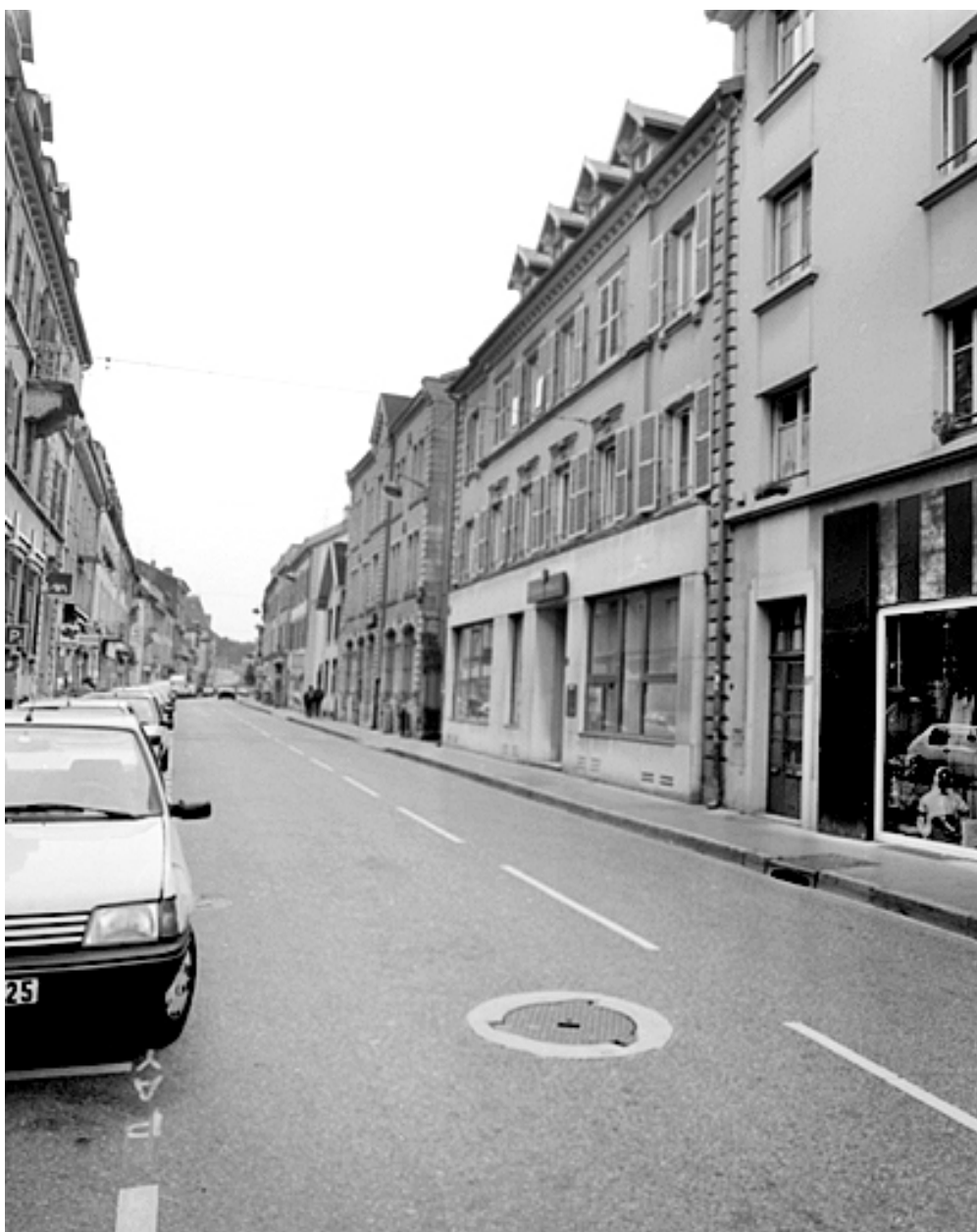
Façades sur rue depuis l'ouest.
