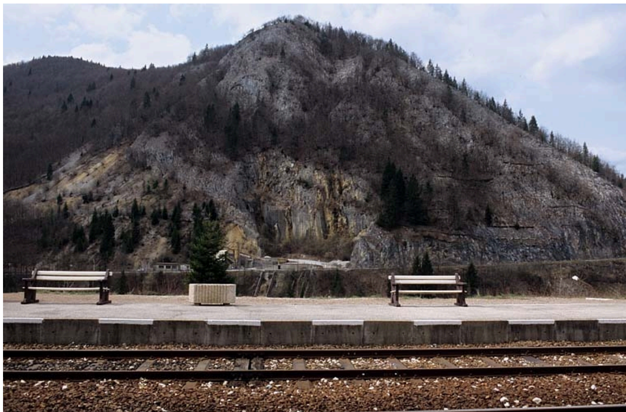
Quai et bancs face au bâtiment des voyageurs (direction La Cluse).
