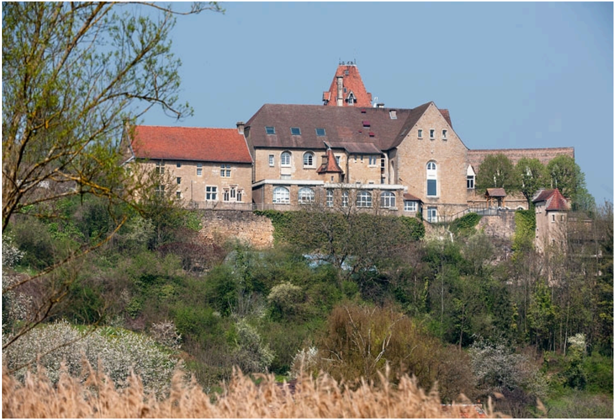
L'ancien couvent des cordeliers, vu de la route de Gouhelans.
