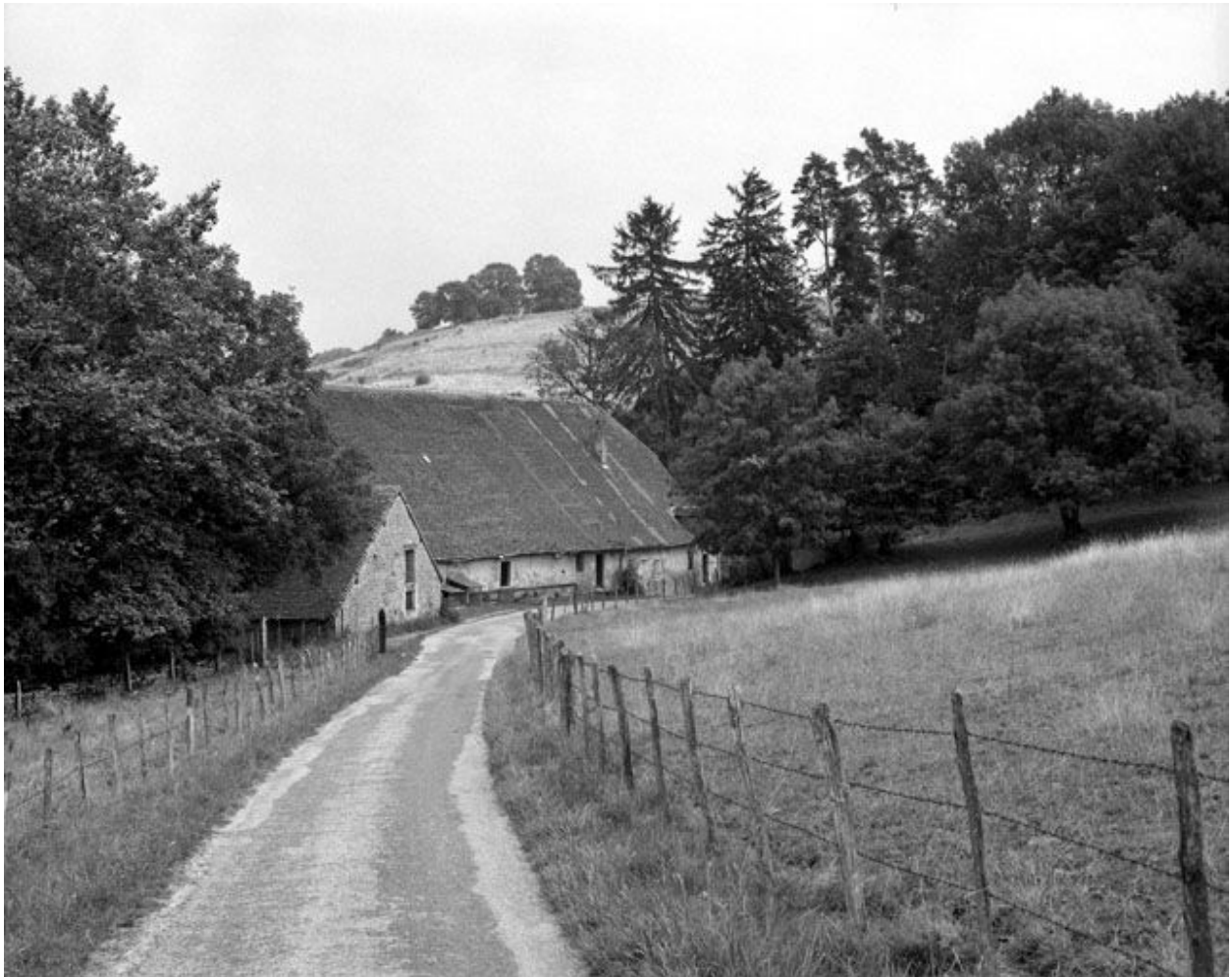
Les parties agricoles vues depuis l'ouest.
