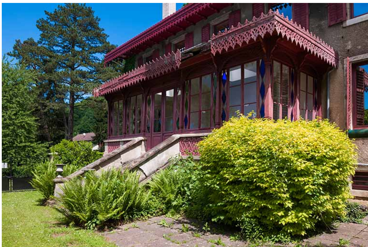
Véranda sur la façade ouest.
