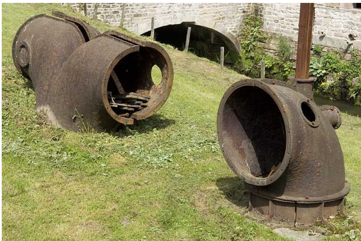
Extrémités de conduites forcées (déposées).
