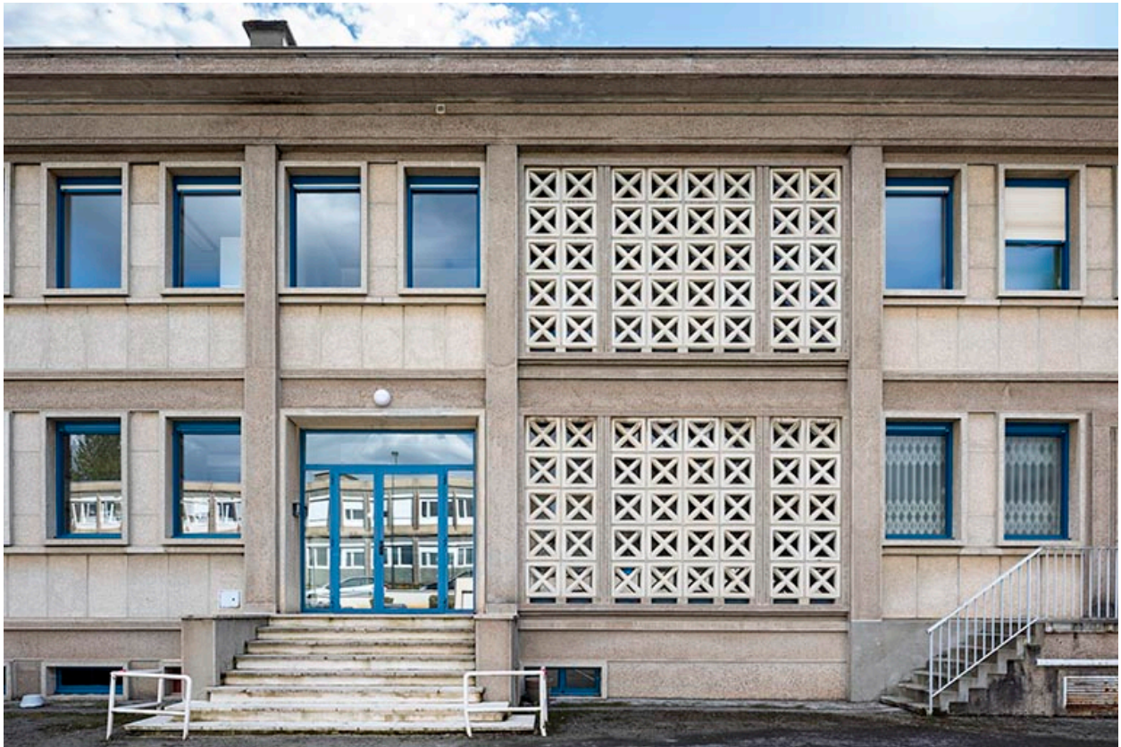
Façade antérieure, corps oriental : travées.
