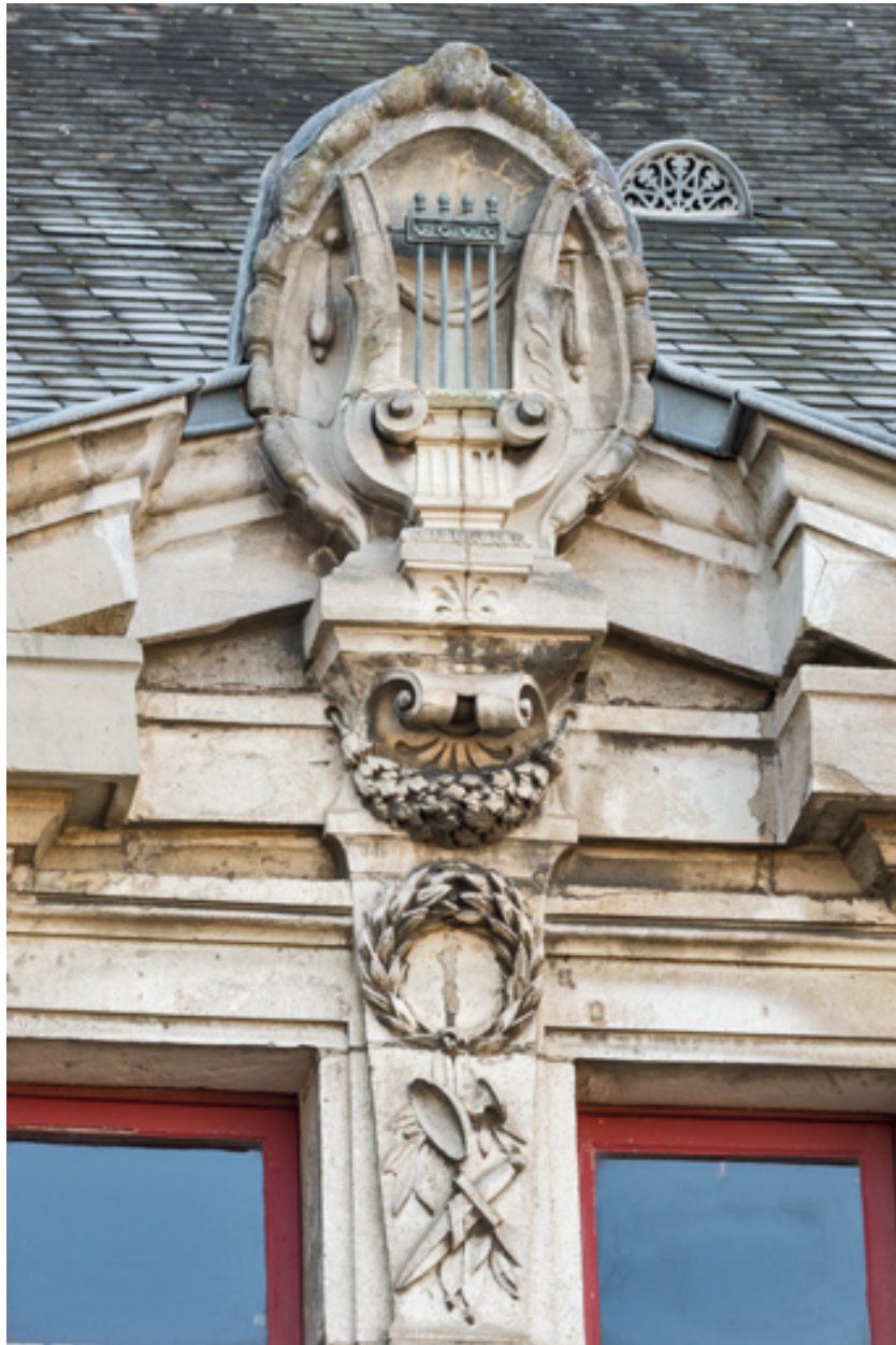
Façade latérale gauche, attique : amortissement de la travée centrale.
