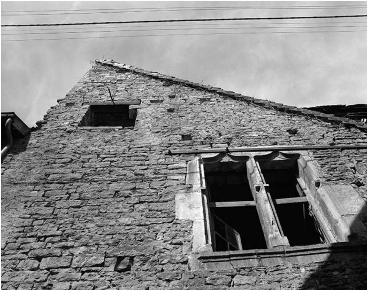
Maison (AE 28, 29) 5 ruelle Gagnemaille : vue du 1er étage et du grenier.
