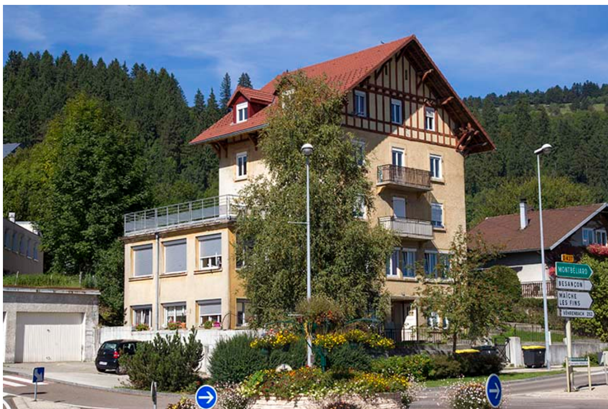
Façades antérieure et latérale gauche.
