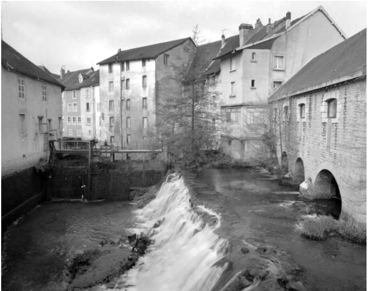
Le bassin de retenue vidé.
