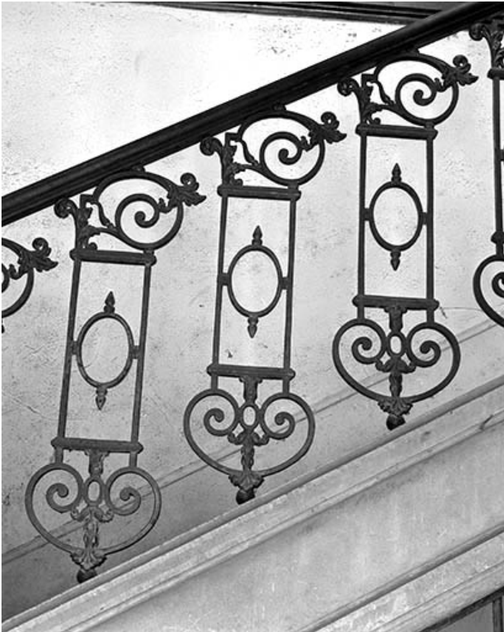
Escalier des bureaux : détail de la rampe.
