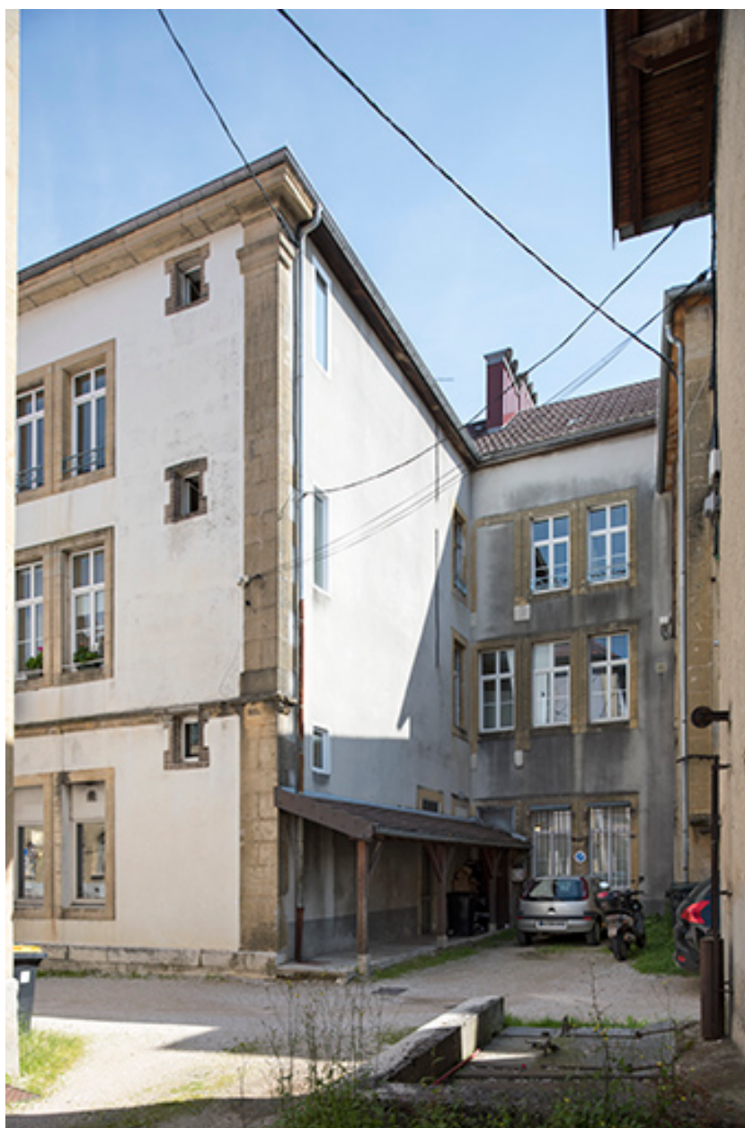
Façades postérieure et latérale droite.
