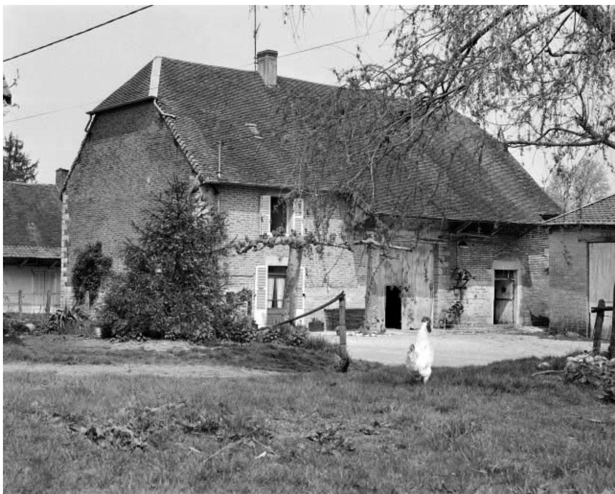
Façades antérieure et latérale droite.
