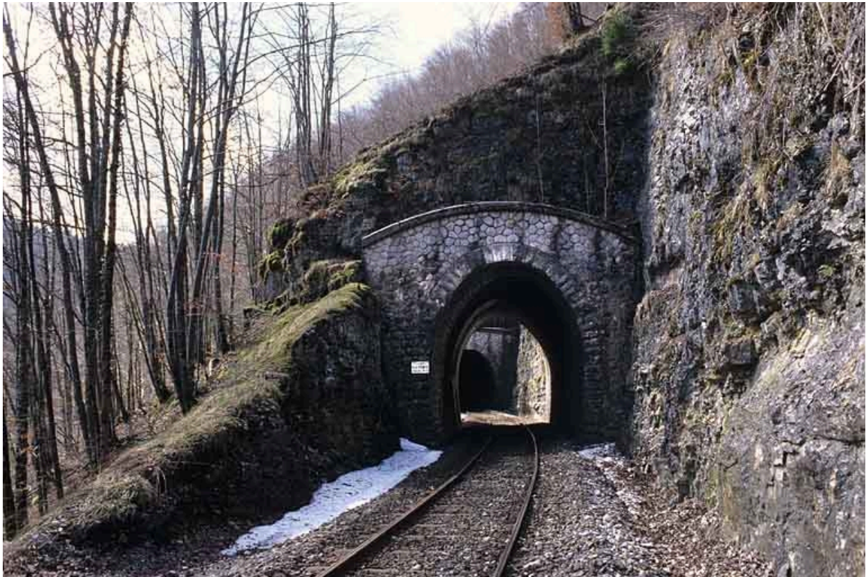
Vue d'ensemble, côté Andelot-en-Montagne (nord). Tunnel du Grépillon à l'arrière-plan.
