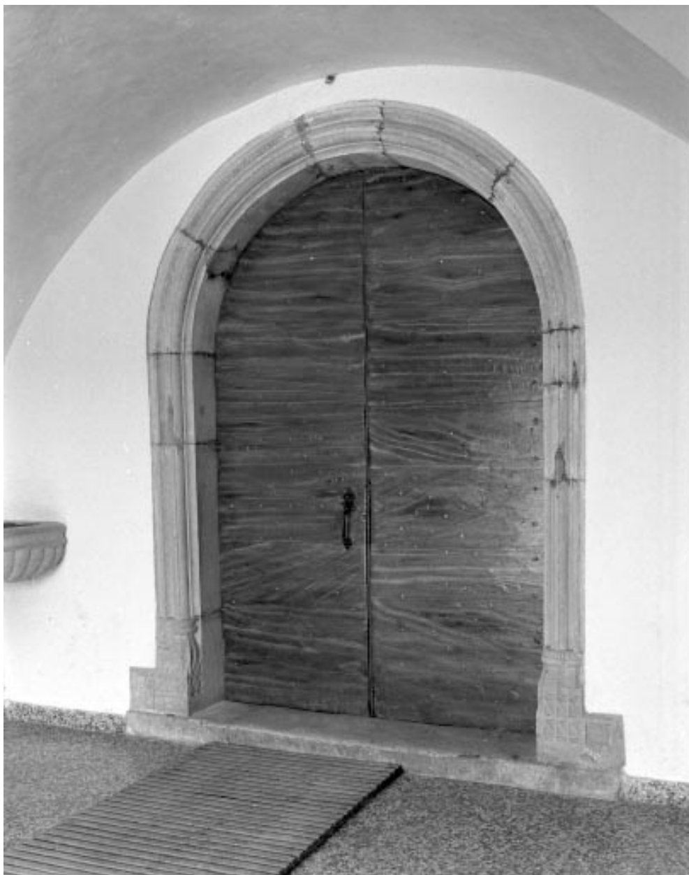
Le portail d'entrée de la nef.
