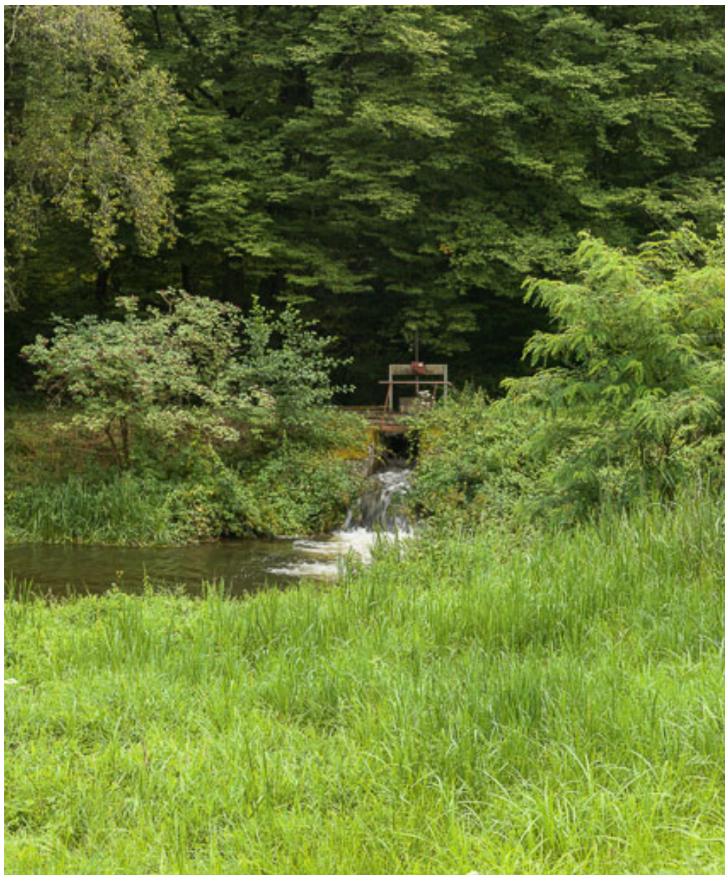
Vue des prises d'eau.
