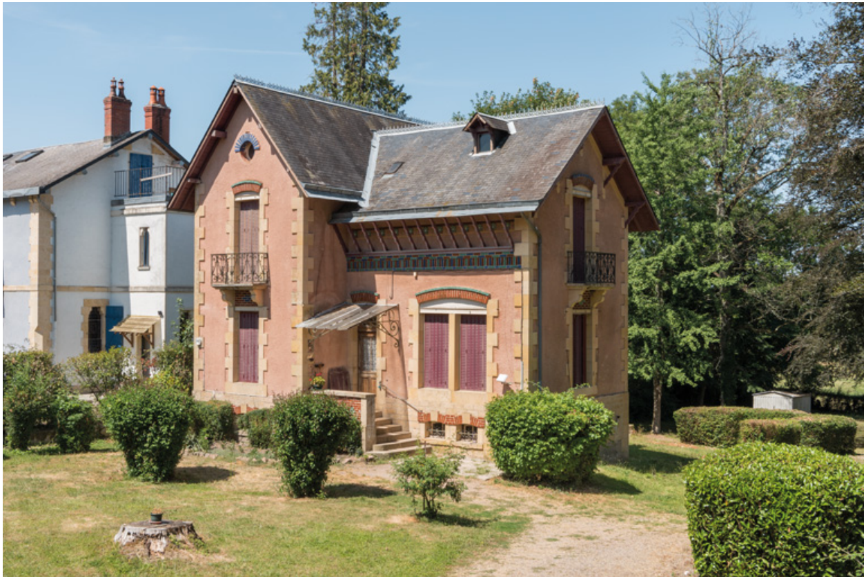
Façade sur l'avenue de Rémilly.
