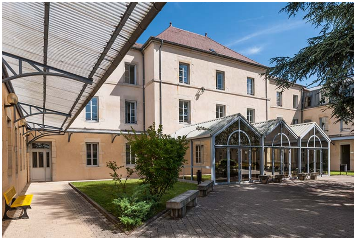
Façade postérieure du pavillon d'entrée
