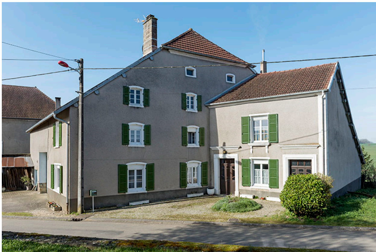
Maison ferme 23 Grande rue.
