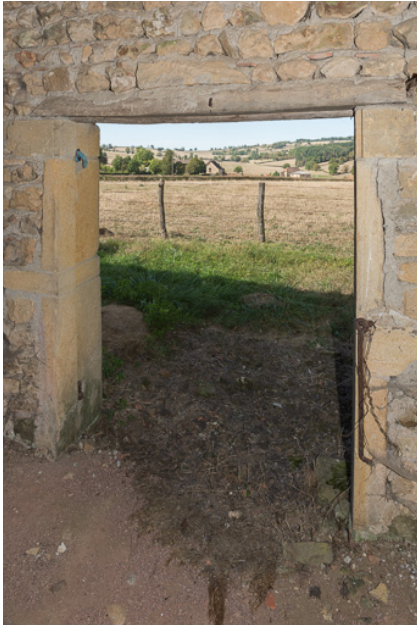
Vue du paysage environnant, depuis l'ouverture au fond du hangar
