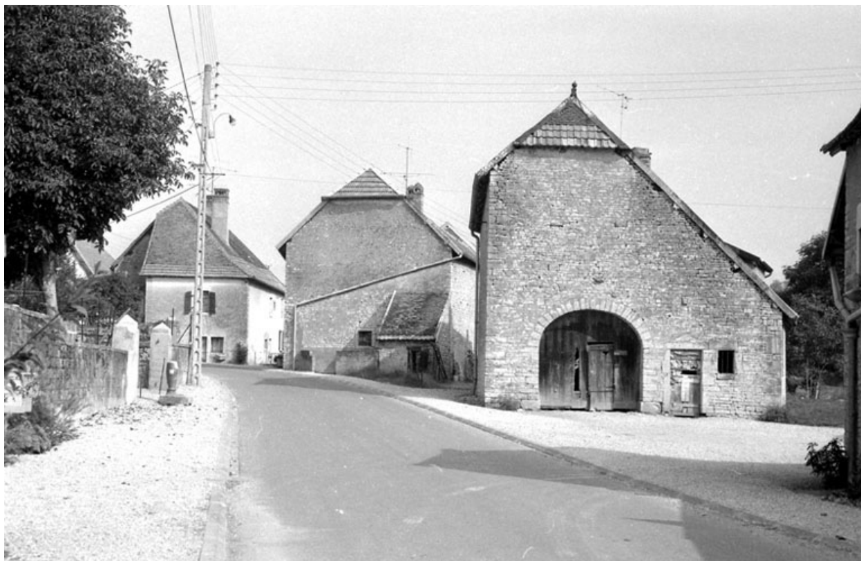
Façade latérale droite.
