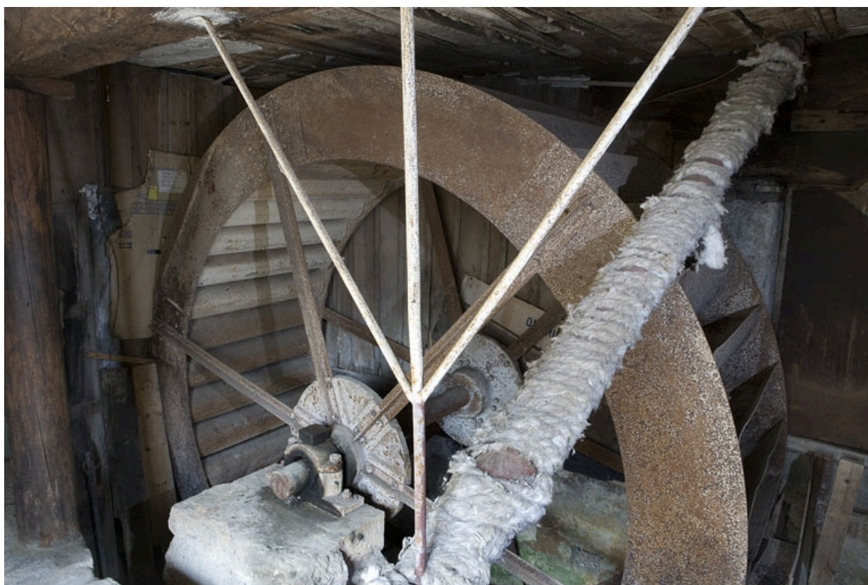
Roue hydraulique verticale, depuis l'amont.
