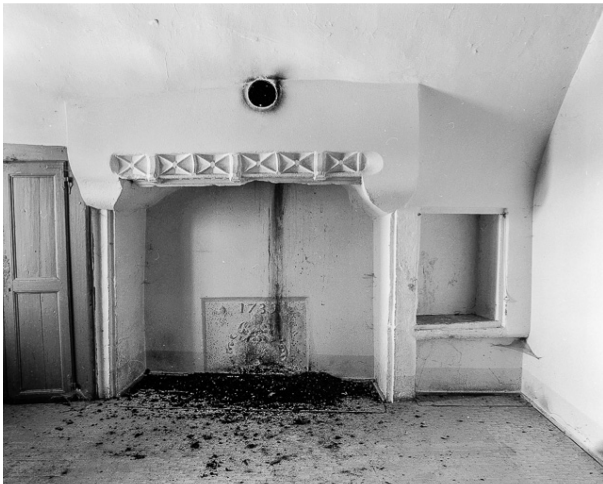
Corps de logis, cheminée.
