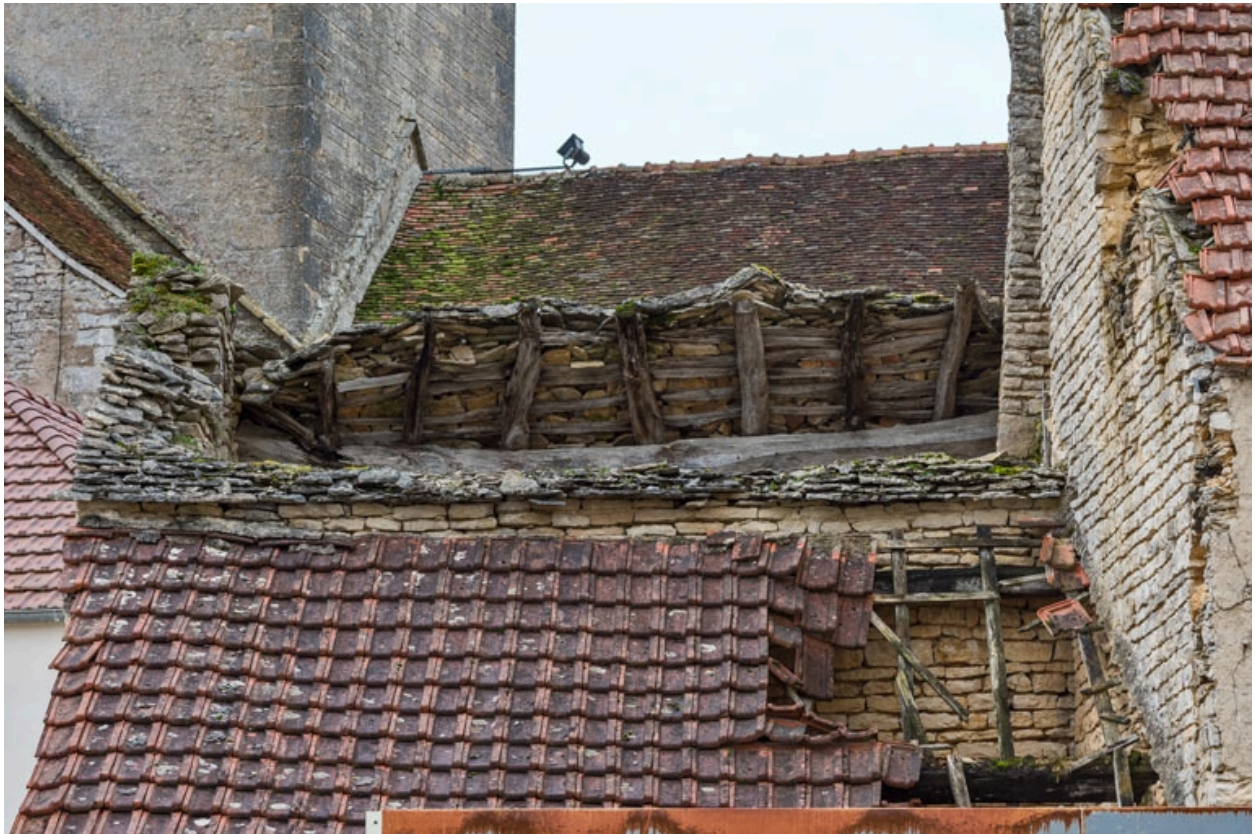
Détail de la toiture côté est.
