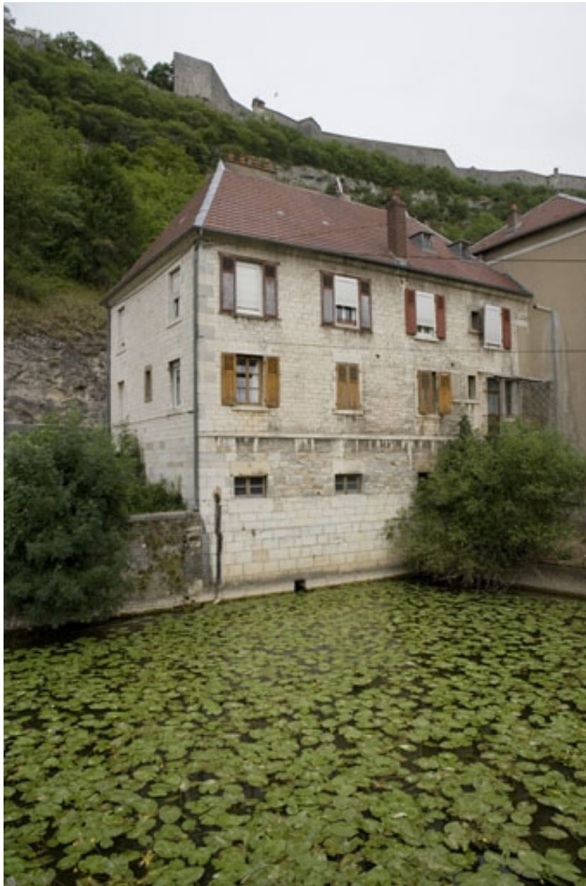
Façade postérieure du bâtiment de logement et bureau.
