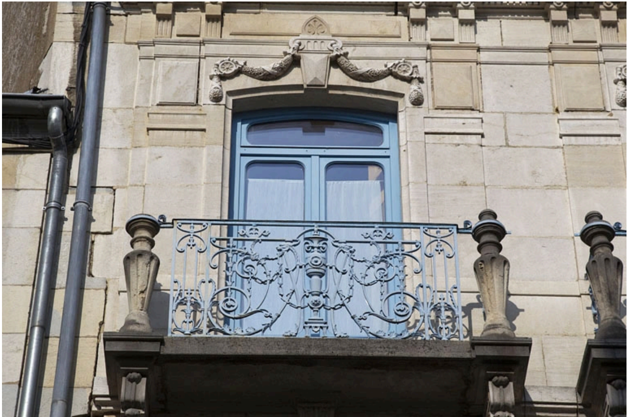
Deuxième logis secondaire, façade sur rue, deuxième étage : détail du balcon gauche.
